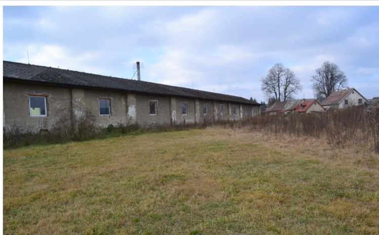
Na tomto mieste by sa mal vybudovať zberný dvor.
